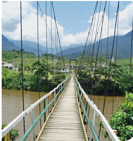
Eine Hängebrücke führt zum Klinikgelände.
