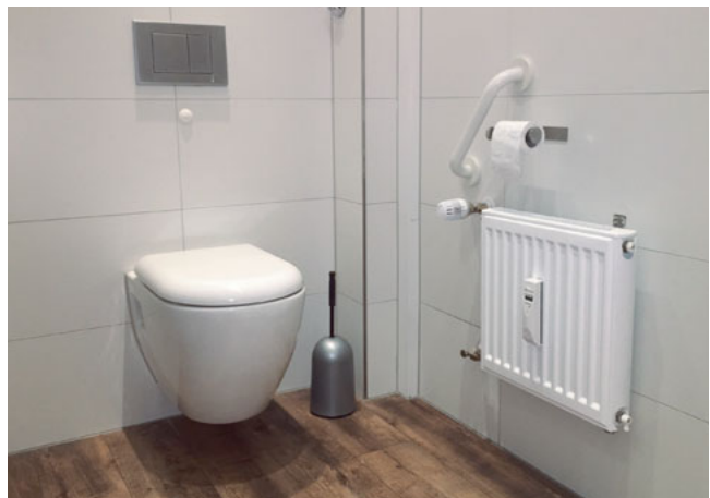
Abb. 6 Haltegriffe neben den Toilettenbecken sind wichtig.
