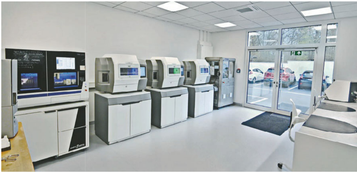
Abb. 7 Direkt neben der CAD/CAM-Abteilung findet sich ein separater, speziell gebauter Raum für die CNC-Maschinen. Neben einer entkoppelten Bodenplatte und einem eigenen großen Zugang von außen zeichnet sich der Raum durch eine zusätzliche Schallsolierung und eigenständige Klimatisierung aus.
